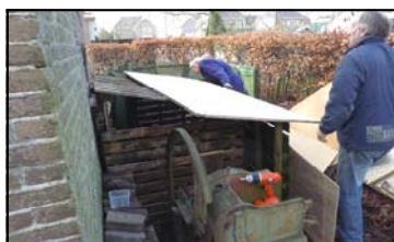
Bouw onderduikersplek bij Westerhem
